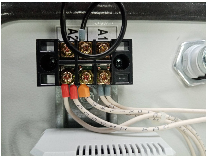
Рисунок 9. Клеммная колодка ХТ2 и провод «ОБУЧЕНИЕ».
